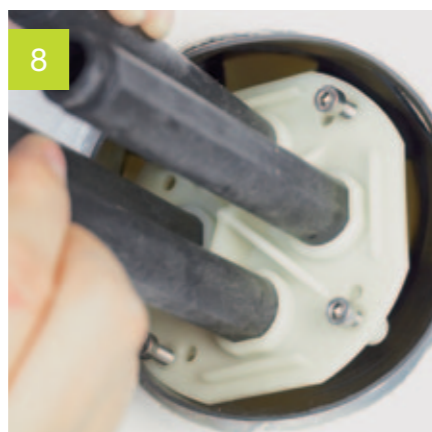
8 Jednoduše vyjmout proplachovací sadu
