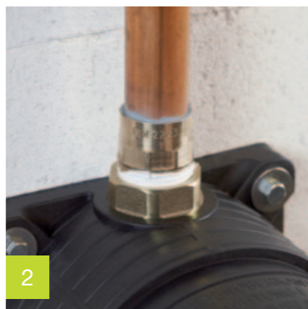
2 Připojení potrubí
