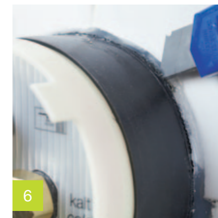
6 Oříznutí – vnitřní část boxu zůstává během celé doby hrubých stavebních prací chráněná před nečistotami
