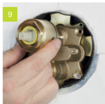
9 Namontovat funkční jednotku
