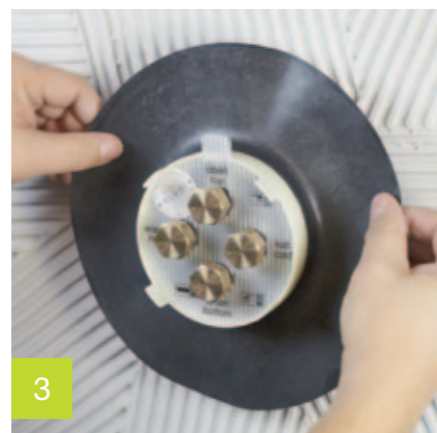
3 Začištění a nalepení těsnící manžety
