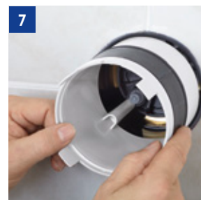
Vytažení pryžového prvku pláště.
