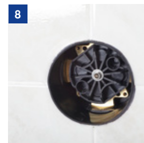
Odstranění proplachovacího modulu.
