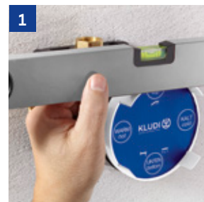
Upevnění podomítkového tělesa.
