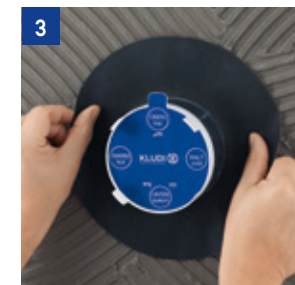
Zaomítnutí a utěsnění těsnící příruby.
